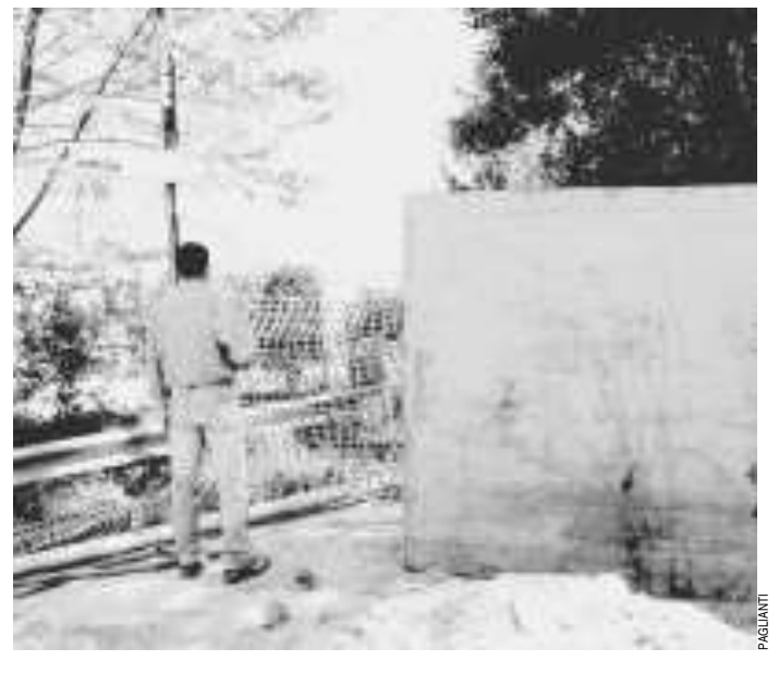
Il cantiere dove è stata trovata la bomba
