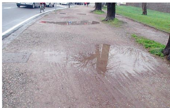
Il marciapiede come si presenta per chi arriva da viale Marconi
